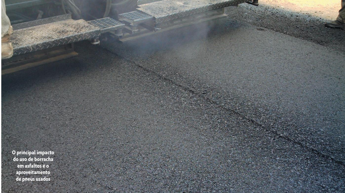
O principal impacto do uso de borracha em asfaltos é o aproveitamento de pneus usados
